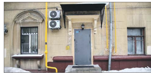
Отдельный вход хозяина помещения прорубил в несущей стене
