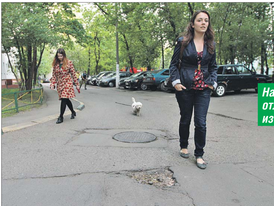
На дворовой территории не только отремонтируют асфальт, но и установят бортовой камень
