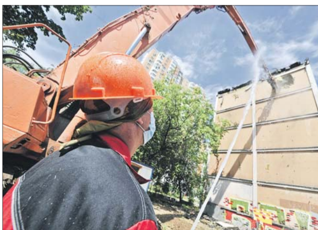
Пятиэтажка на Снежной, 19, корпус 1, пошла под ковш экскаватора
