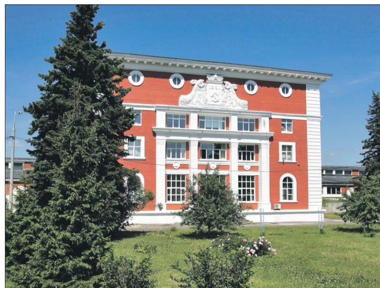
Северная станция стала третьей по счёту в системе водоснабжения Москвы
