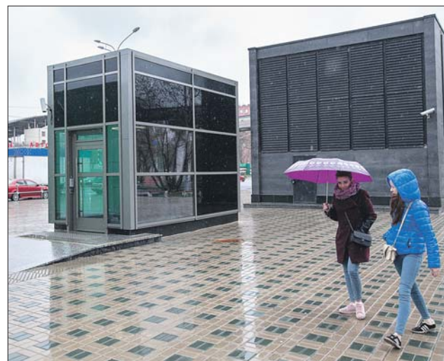
Пусконаладочные работы на лифтах уже завершены
