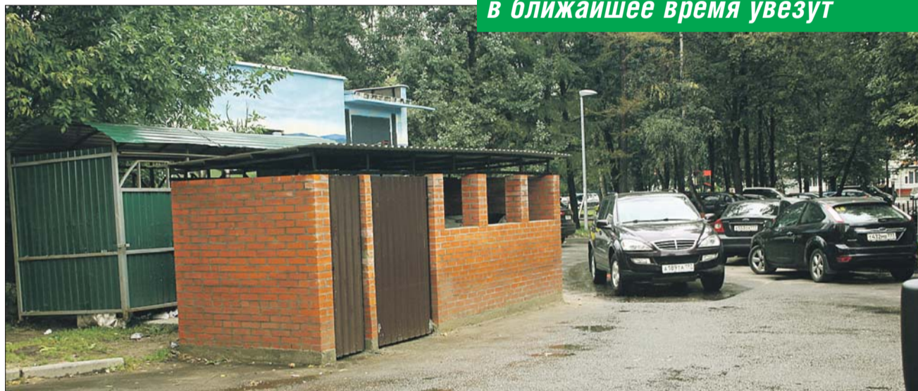
Как выяснилось на месте, проезду машин контейнерная площадка не мешает
