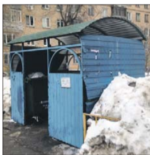
Старая контейнерная площадка на Аргуновской, 4
