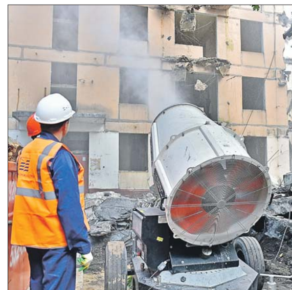
Гидропушка в действии: разборка дома по технологии умного сноса
