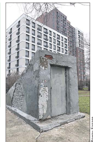
Сооружение — вход в бывшее бомбоубежище вот-вот снесут
