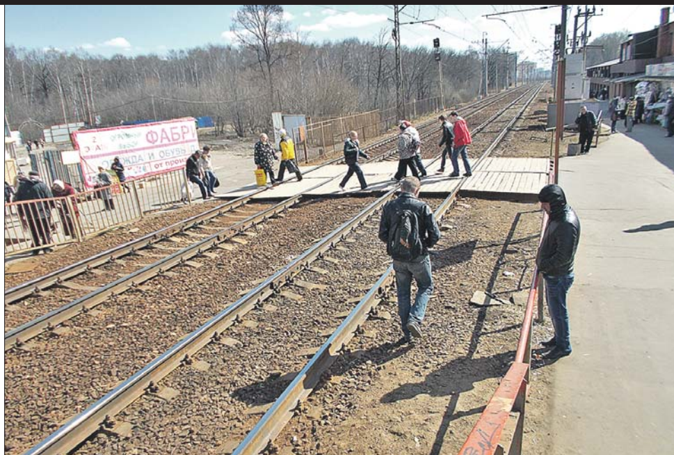
Переход через рельсы ничем не огорожен
