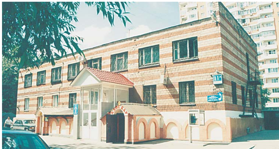
Здесь, на ул. Фонвизина, 11а, надстраивают офисные этажи
