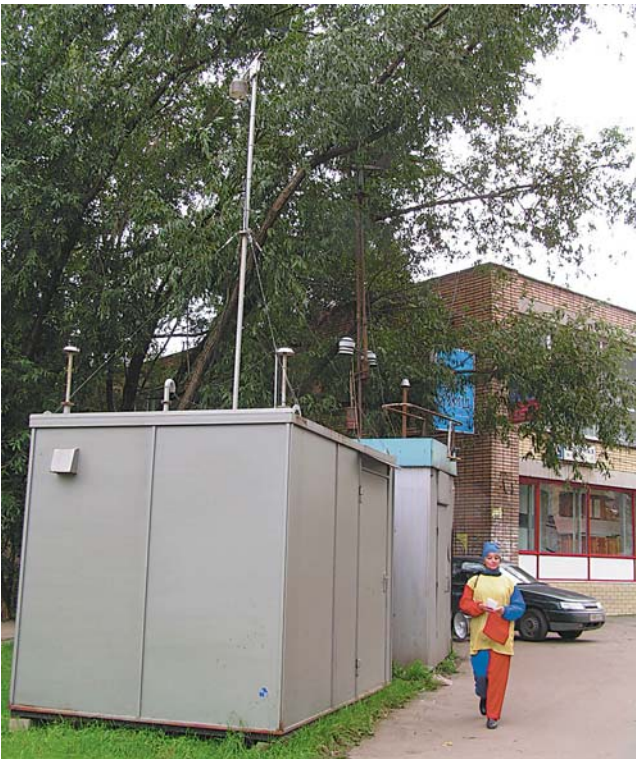
Автоматическая станция контроля загрязнения воздуха
