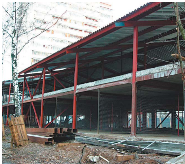
В декабре стройку обещают закончить
