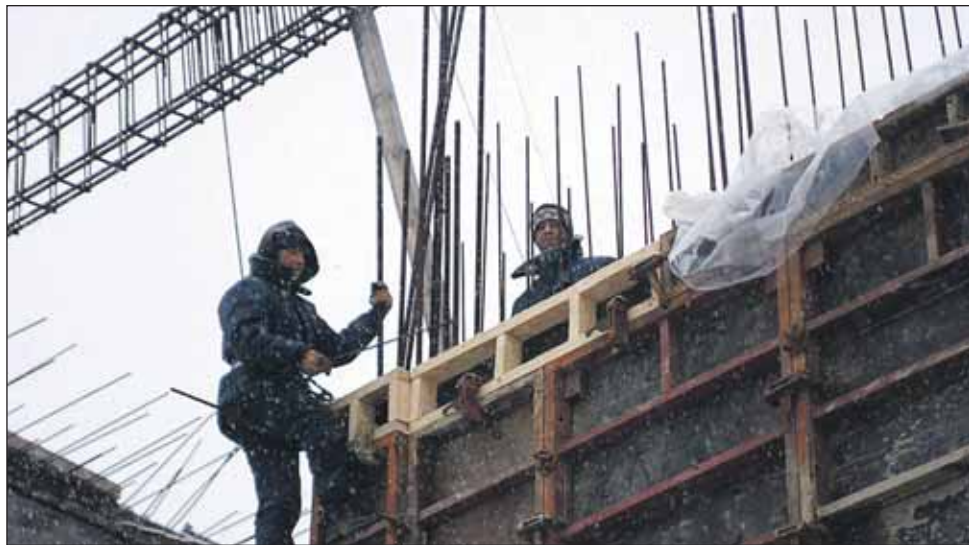
Строительство поликлиники в районе Северный возобновилось
