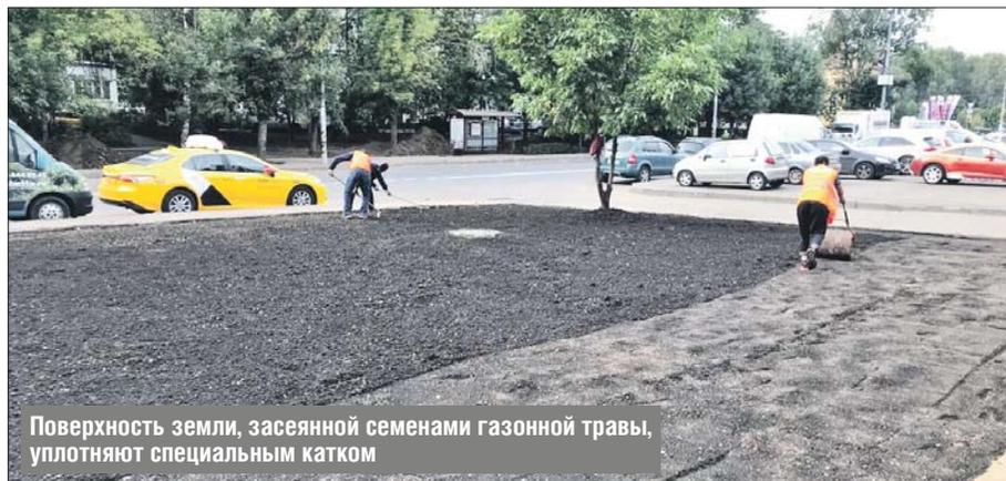
Поверхность земли, засеянной семенами газонной травы, уплотняют специальным катком
