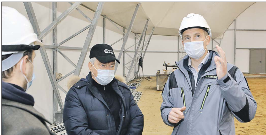
Префект СВАО Алексей Беляев проверил, как идёт строительство спорткомплекса на Юрловском проезде
