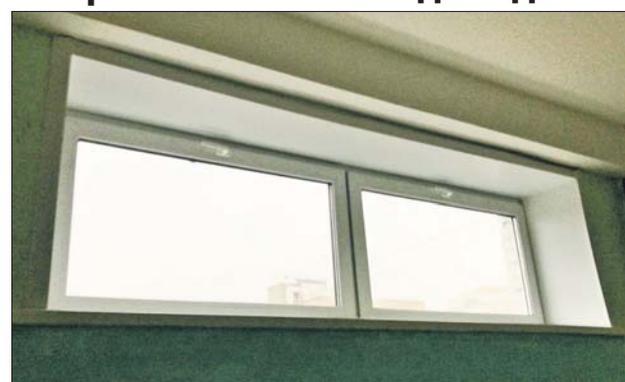
Работу по отделке окна завершили: установлены и закреплены пластиковые откосы
