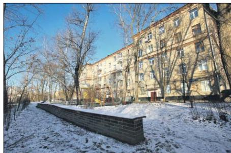
Подпорная железобетонная стена длиной 130 метров находится перед крутым склоном к Яузе и уходит на 2 метра под землю
