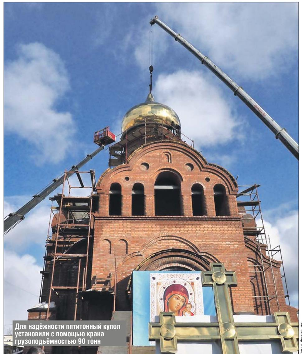
Для надёжности пятитонный купол установили с помощью крана грузоподъёмностью 90 тонн
