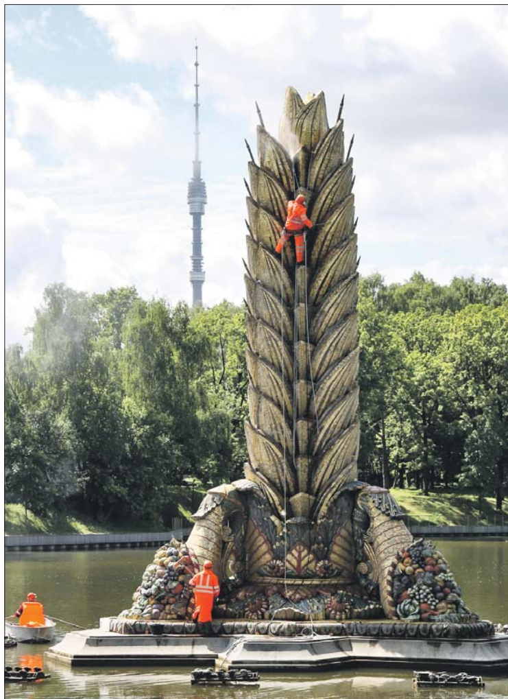
Чтобы забраться на вершину 16-метрового сооружения, рабочие используют альпинистское снаряжение
