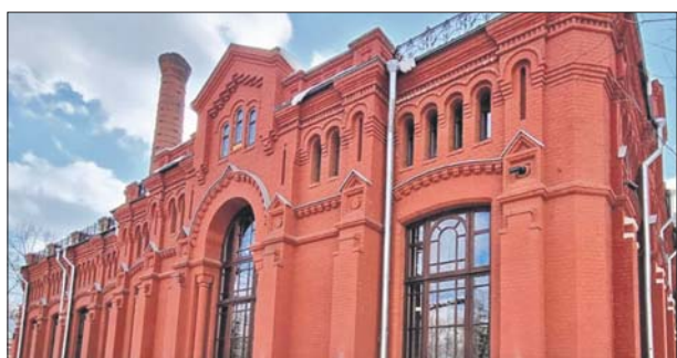
Так Алексеевская насосная станция выглядит сегодня
