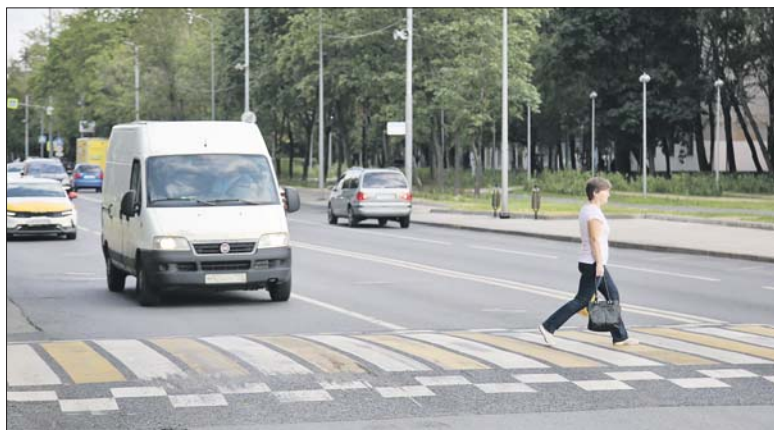
Перед такой рельефной разметкой водители заранее будут снижать скорость
