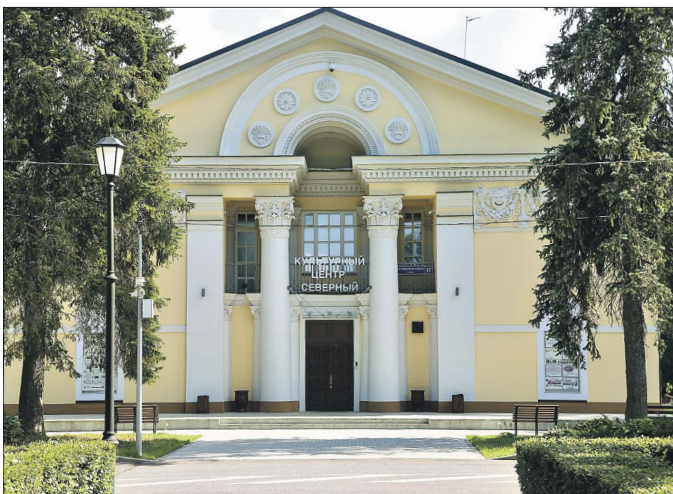
Здание дома культуры «Северный» построили 70 лет назад. Сейчас в нём находится одноимённый культурный центр
