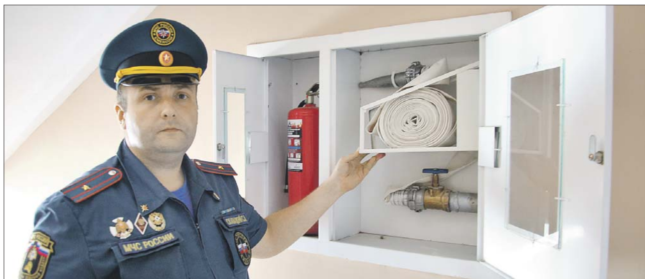
Майор внутренней службы Станислав Скалацкий показывает, как должен выглядеть образцовый пожарный шкаф
