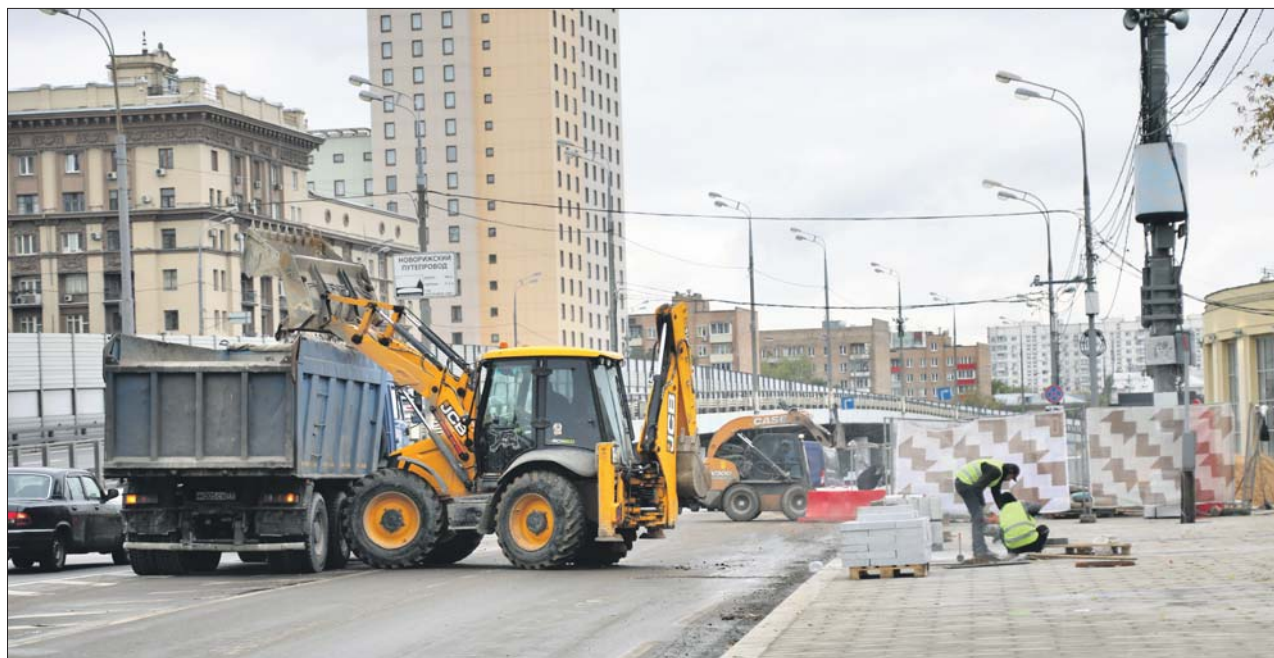
Сейчас строители приводят в порядок улицы рядом со станцией метрополитена по обеим сторонам Третьего транспортного кольца
