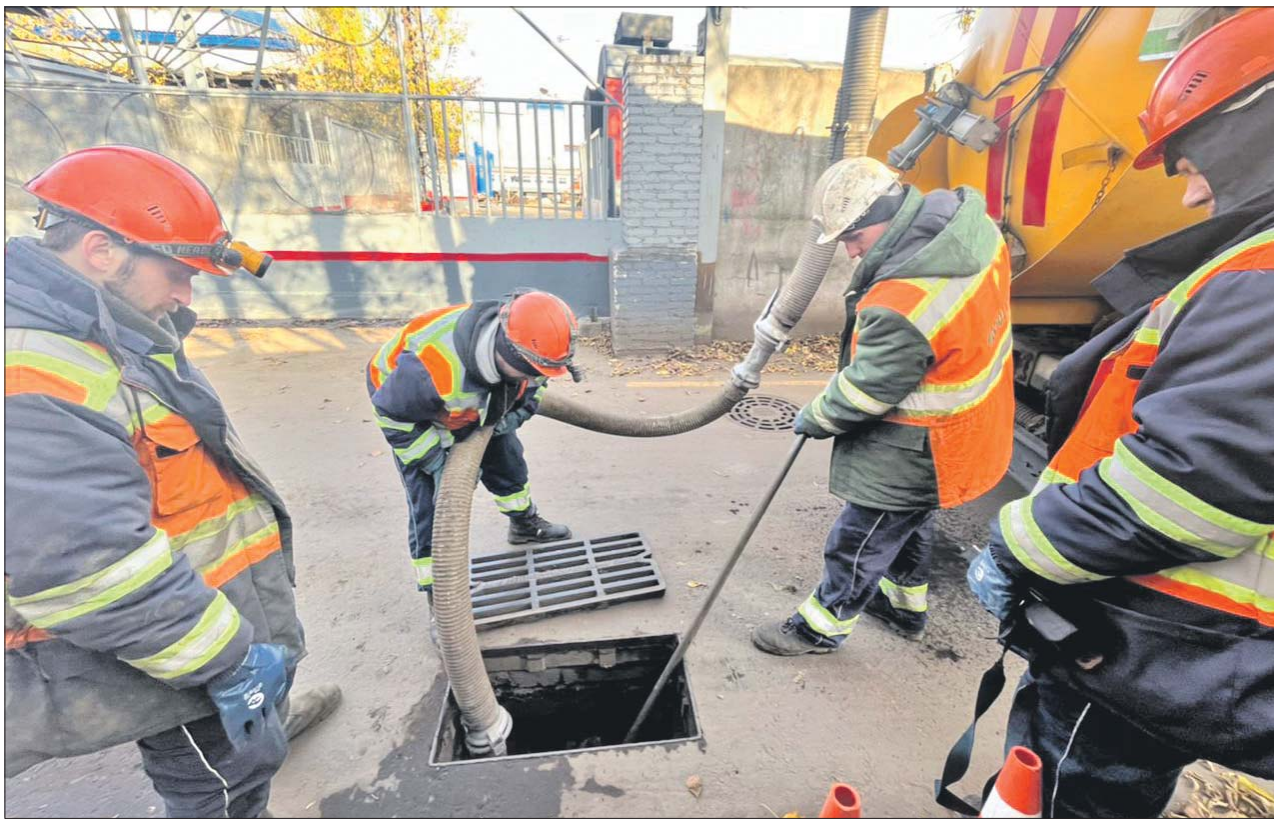
Рабочие опускают в канализацию шланг вакуумной машины — илососа
