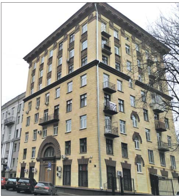
Дом 124, корпус 17, на проспекте Мира
