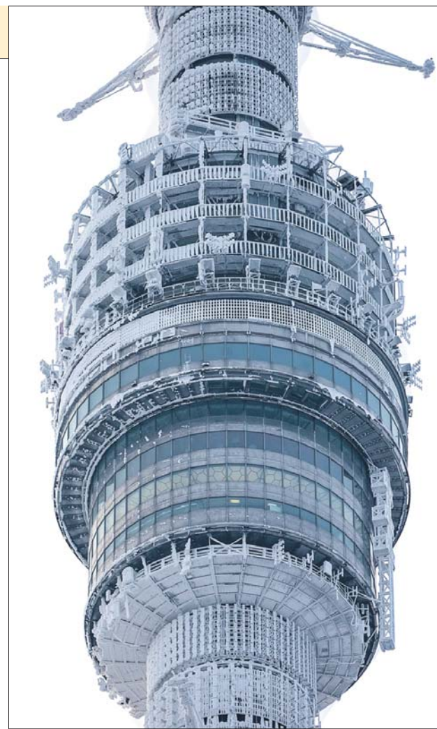
Причудливая изморозь на железе и на бетоне образовалась при замерзании водяного пара
