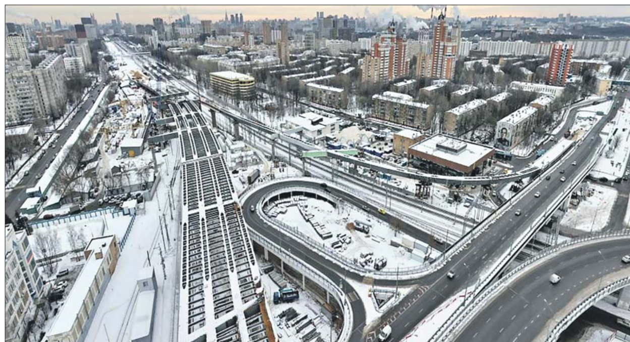
Строительство северного дублёра Кутузовского проспекта близится к завершению
