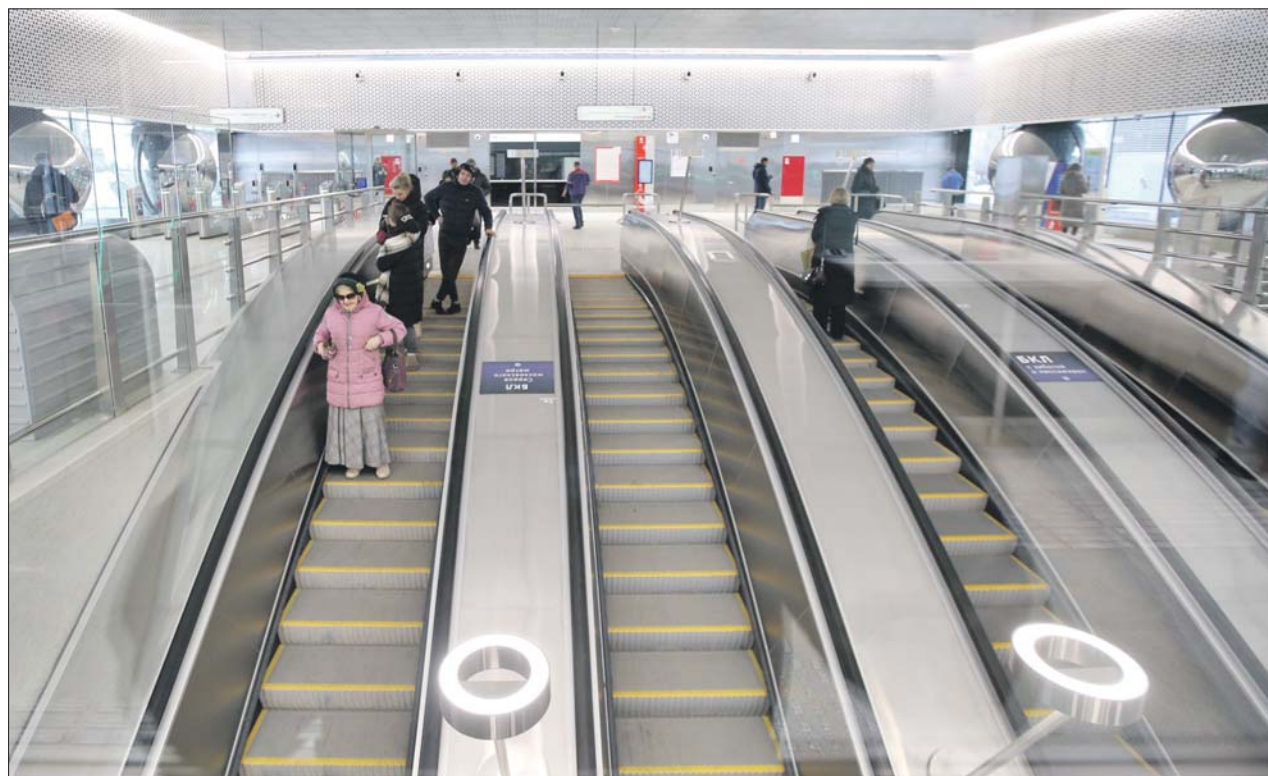
Протяжённость эскалаторов на станции БКЛ «Марьино Роцца» достигает 130 метров
