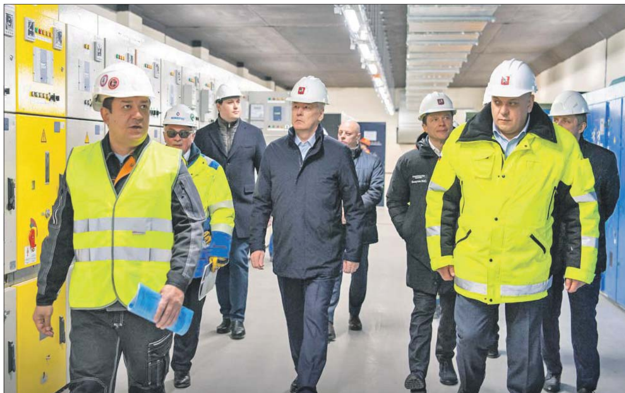
Сергей Собянин проверил ход строительства станции метро «Аэропорт Внуково»
