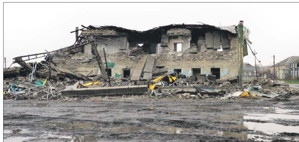
Разрушения от ударов ВСУ по Сватову. В школе №2 учатся ребята, лишившиеся домов. Их приютили соседи
