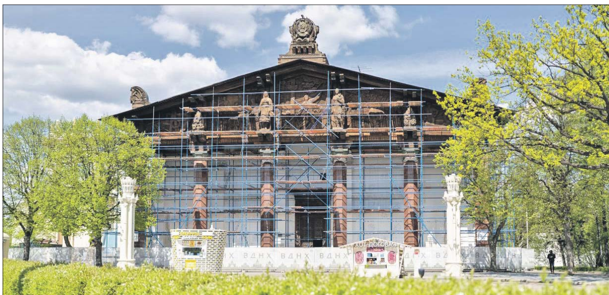
Специалисты восстановят кровлю, деревянный декор, элементы интерьера
