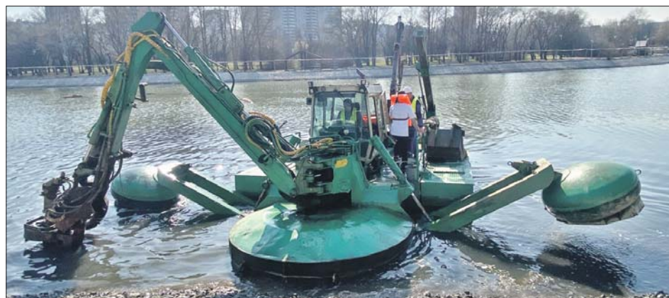
Весной с помощью этого агрегата водоём освобождали от иловых отложений, сейчас очистка завершена
