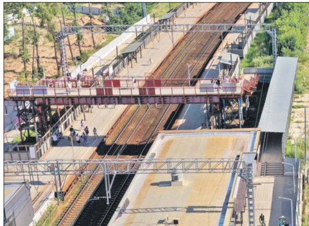
Деревянные платформы и мост возводили на время реконструкции
