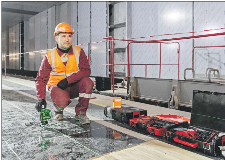
Строительство основных конструкций завершено
