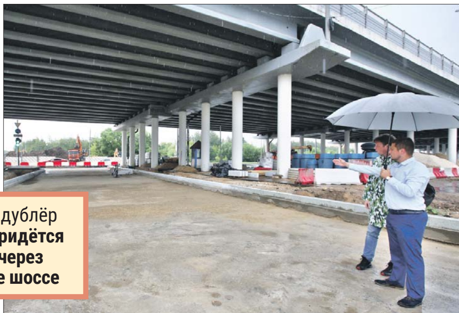
Дорога под эстакадой в сторону метро «Физтех» почти готова
