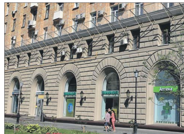
В порядок привели облицовку первого этажа
