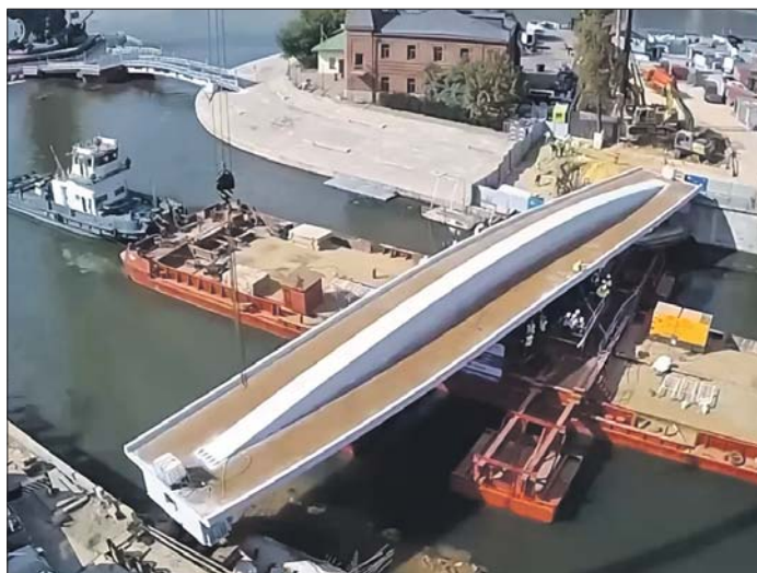
Мост в процессе монтажа на заранее подготовленные опоры
