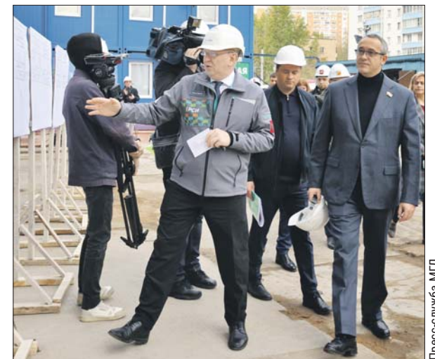
Во время посещения стройплощадки Алексей Шапошников пообщался с проектировщиками
