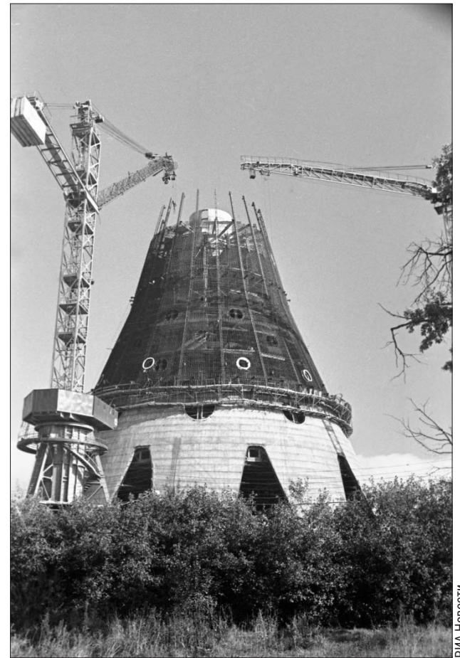
1966 год: строительство Общесоюзной радиотелевизионной передающей станции имени 50-летия Октября
