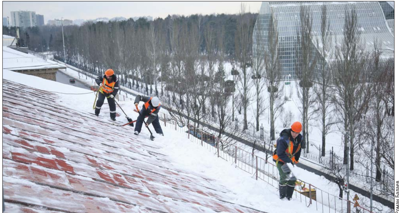
Очистка кровли дома 27 на Ботанической улице
