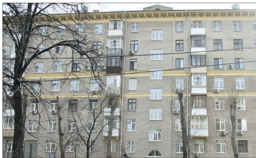
Дом на Бочкова, 5, украшают межэтажные пояса и карниз под крышей
