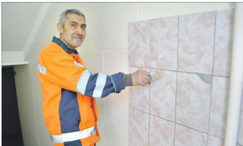
Во время косметического ремонта в доме на улице Гончарова обновили плитку
