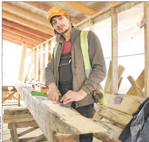
Плотник-реставратор Андрей Тюрин за работой
