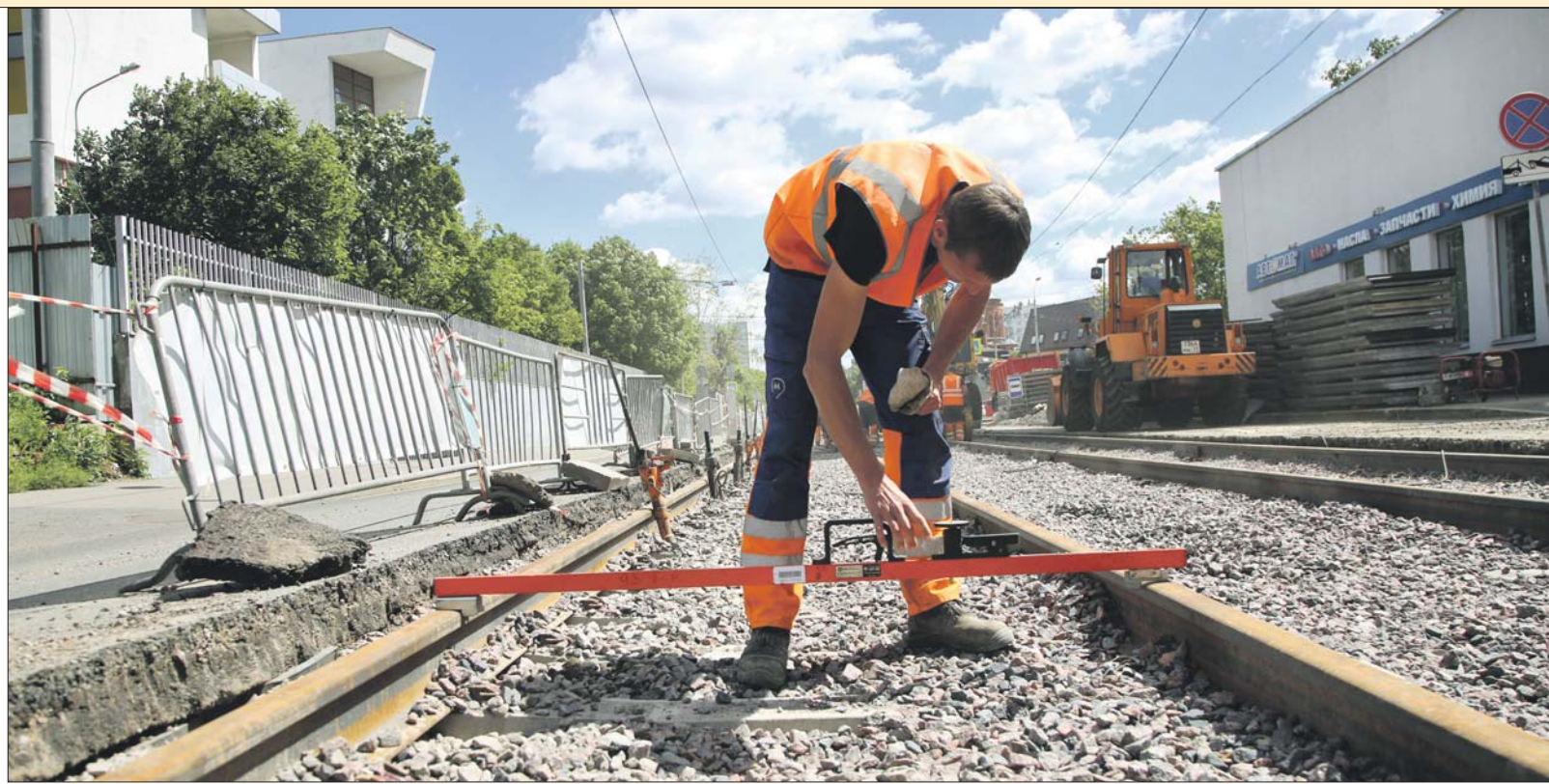
Рабочий проверяет ширину путей, смонтированных между улицами Октябрьской и Советской Армии
