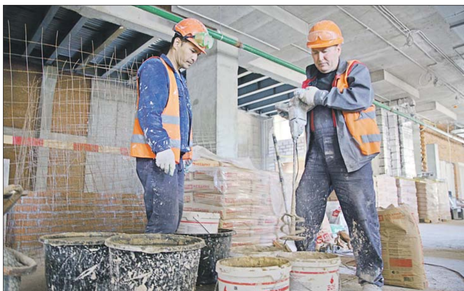
Рабочие ведут черновую отделку, прокладывают коммуникации
