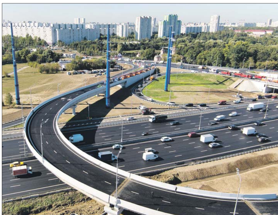
Устаревшую развязку «клевер» заменили конструкцией с прямыми съездами, где потоки машин не пересекаются
