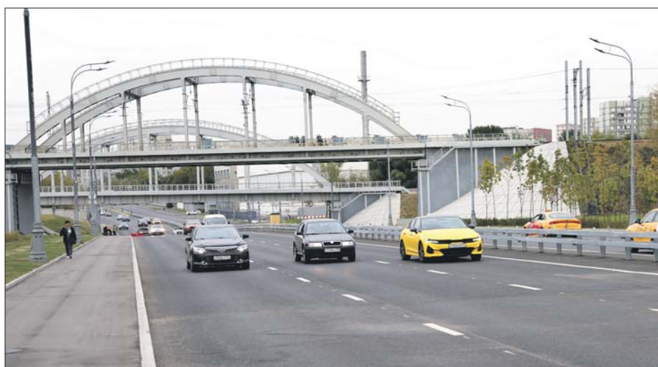
На новой связующей дороге сделали по три полосы для проезда в обе стороны
