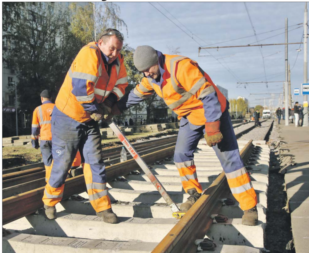
Рабочие скрепляют рельсошпальную решётку на Енисейской улице
