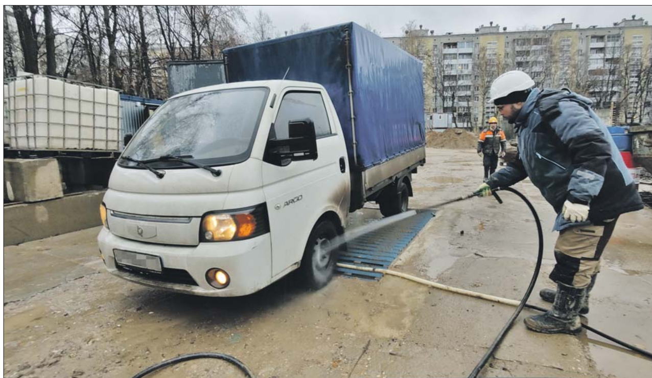
За чистой машин, выезжающих со стройки на Тайнинской улице, теперь следят тщательнее
